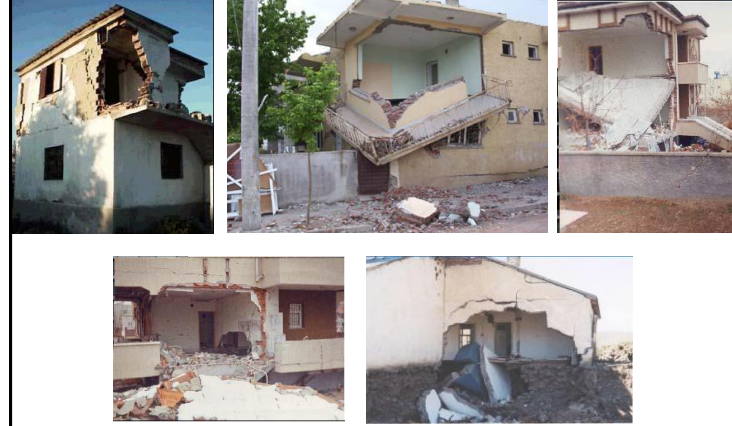
Kısmi Göçme Durumu
