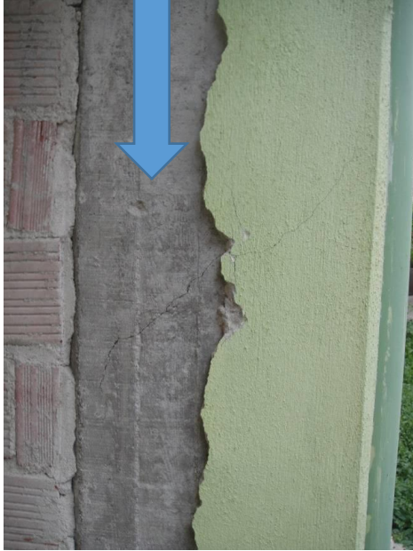
Kesme Çatlağı < 0.5 mm
