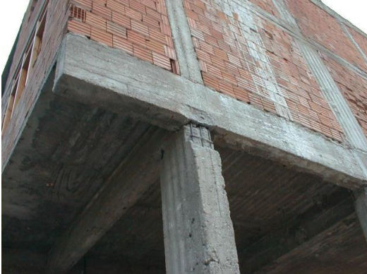
Kabuk Betonunda Dökülme
