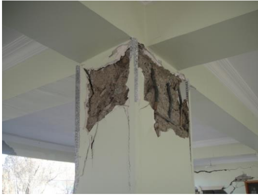
Donatı Burkulması Çekirdek Ezilmesi
