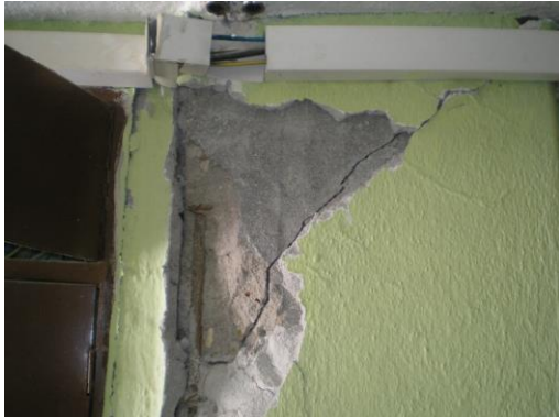
Kesme Çatlağı > 2 mm Kabuk Betonunda Dökülme
