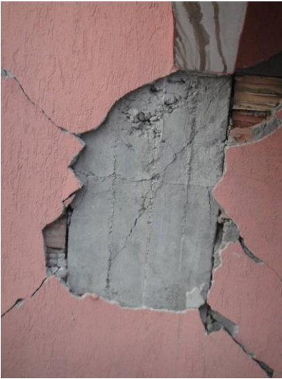
Kesme Çatlağı < 2 mm Kabuk Betonunda Ezilme
