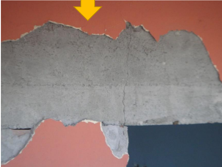
Eğilme Çatlağı < 0.5 mm
