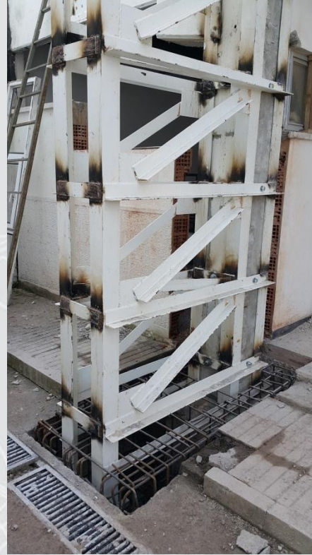
Çelik Kafes Eklenmesi
