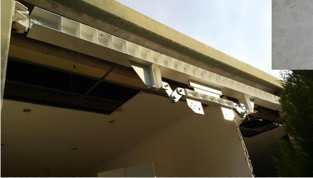
Sönümleyici Üst Kiriş ve Çapraz ayağı Montajı
