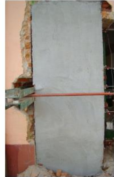
Tekstil hasır donatılı harç ile güçlendirilmiş duvar
