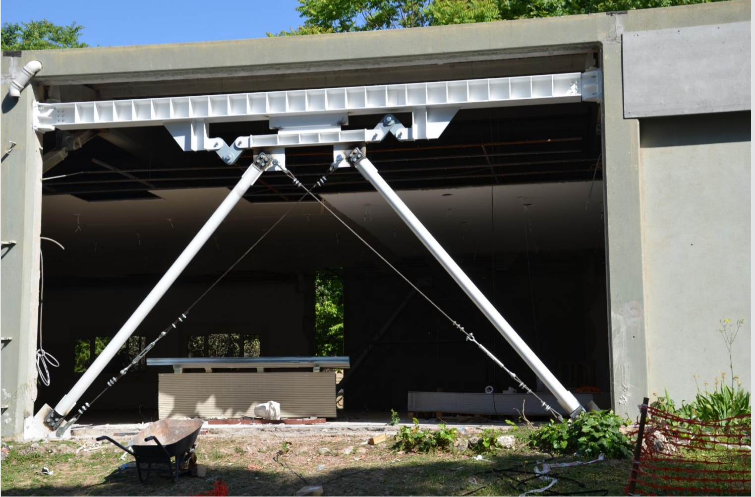
Beton Prefabrik Yapı Güçlendirilmesi
