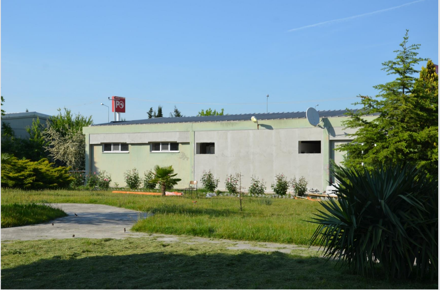
Beton Prefabrik Yapı Güçlendirmesi
