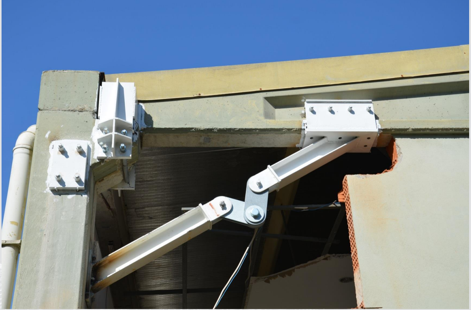
Beton Prefabrik Yapı Güçlendirmesi
