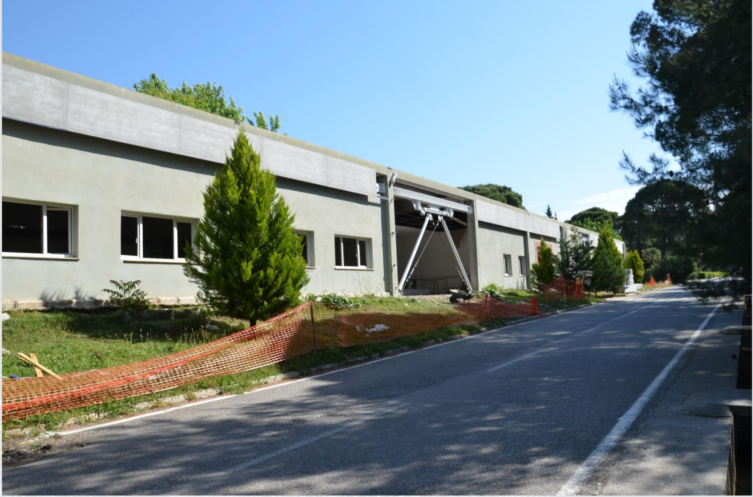
Beton Prefabrik Yapı Güçlendirmesi
