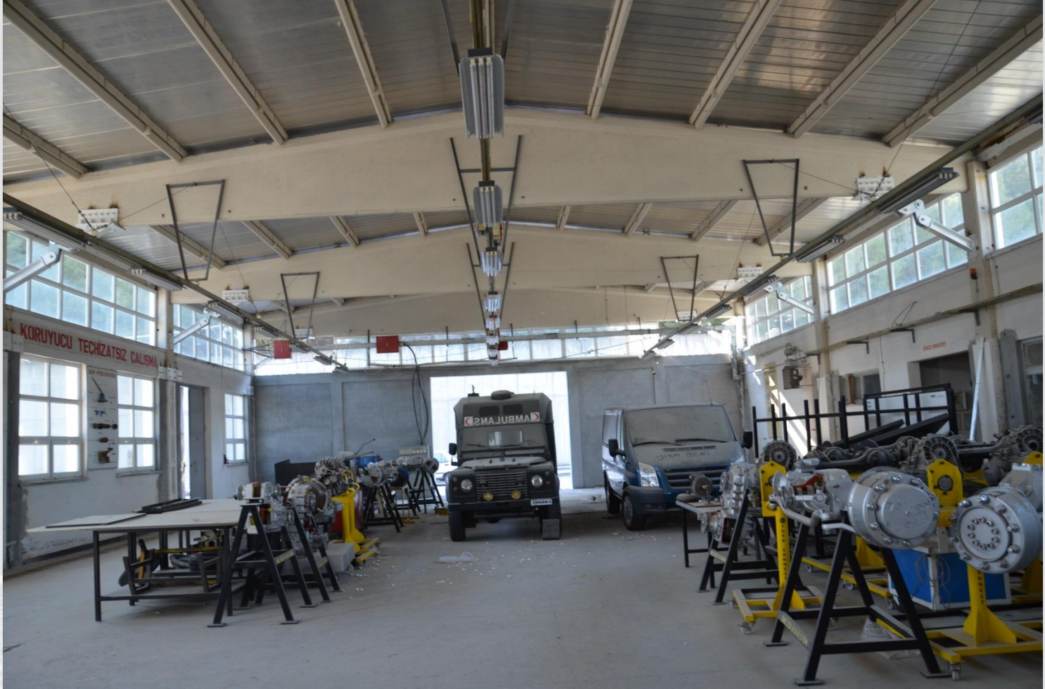
Beton Prefabrik Yapı Güçlendirmesi
