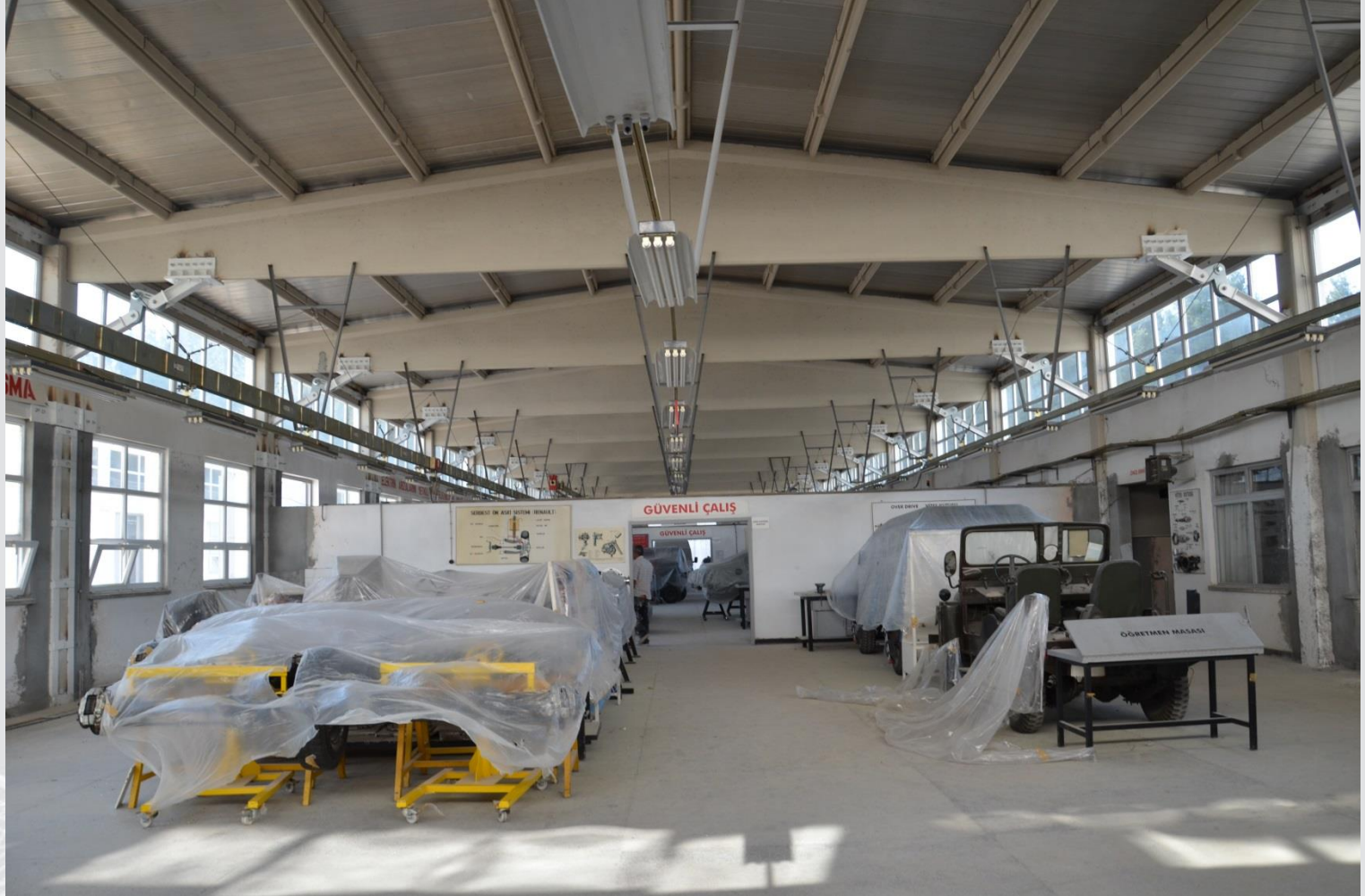
Beton Prefabrik Yapı Güçlendirmesi
