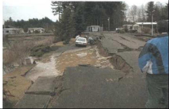
2001 Nisqually depremi Green River boyunca oluşan yanal yayılma
