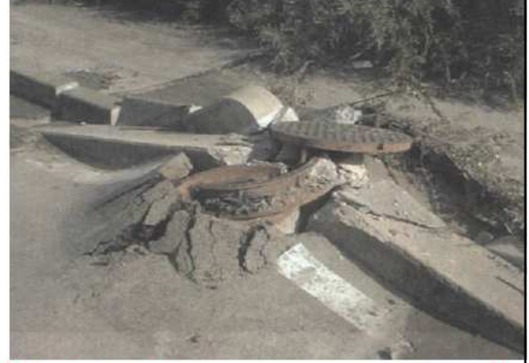
2000 Tottori depreminde sıvılaşma sonucu muayene bacası yükselmiştir
