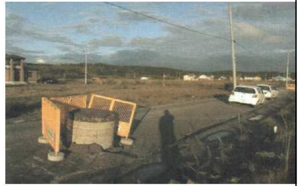
2000 Tottori depreminde sıvılaşma sonucu muayene bacası yükselmiştir
