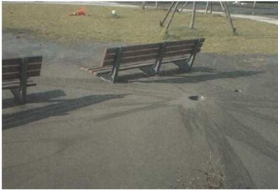
2000 Tottori depreminde oluşan kum kaynamaları
