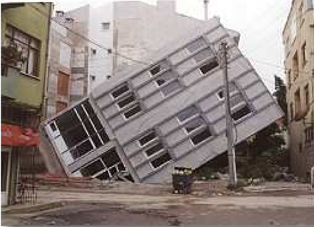
1999 Gölcük depremi nedeniyle oluşan sıvılaşmanın yol açtığı taşıma gücü kaybının Adapazarı'nda bir binaya etkisi ( www.learn-hazards.org )
