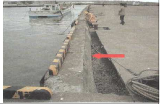
1995 Kobe depreminde sıvılaşma sonucu oluşan istinat duvan ye
