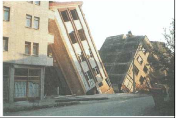
1964 Niigata depreminde sıvılaşma sonucu devrilen binalar
