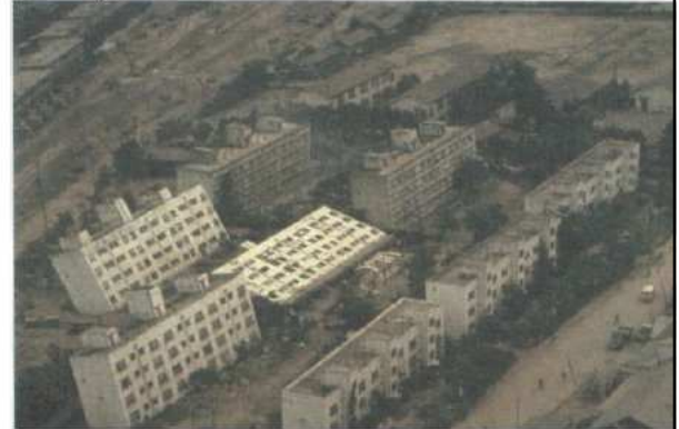
1964 Niigata depreminde sıvılaşma sonucu devrilen binalar
