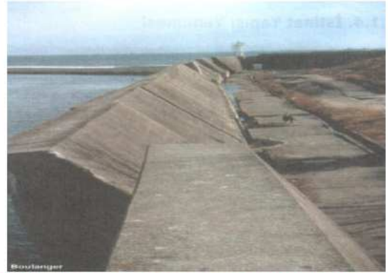
1995 Kobe depreminde sıvılaşma sonucu oluşan istinat duvan ye
