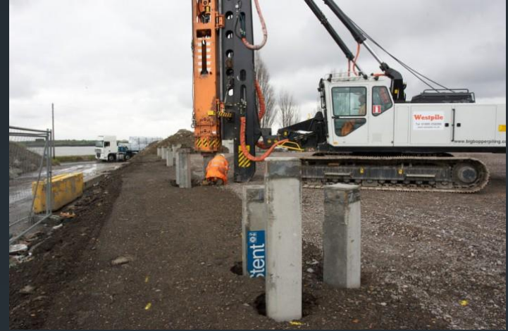
Prekast Betonarme Çakma Kazık
