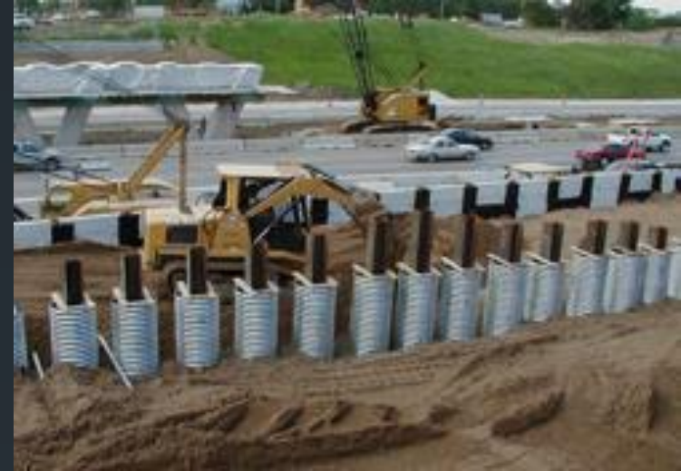
Çelik Profil Çekirdekli Beton Kazık
