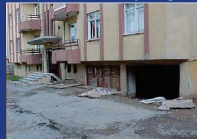
Zeminde Sıvılaşma Sonucunda Meydana gelen Hasarlar
