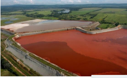
Ekim 2010 Macaristan, maden atık seddesinde göçme
