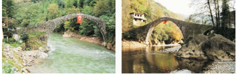
Şekil 1. Tarihi Osmanlı taş kemer köprüsüne ait bazı görünüşler
