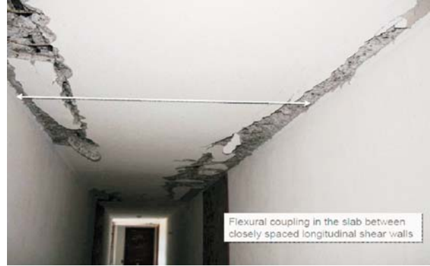
Şekil 11. Birbirine çok yakın iki perde arasında “bağ kirişi” gibi zorlanmış döşeme kenarlarında eğilme çatlakları.
