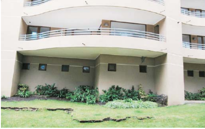
Şekil 13. Çok katlı yapının yüzeye çok yakın radye temelinde dönme.
