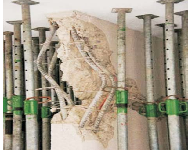
Şekil 10. Eğilme momentinden dolayı perde uç donatısı burkulması. Uç donatıları etriye ile sarılı değil gövde yatay donatılarının perde ucunda 90 derece bükülmüş olması. Boyuna donatıları yeteri kadar sarmamış.
