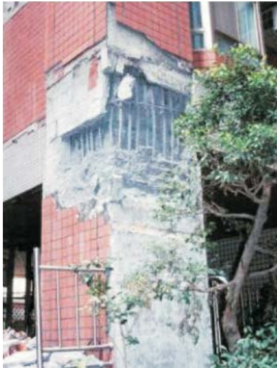
21 Eylül 1999 Tayvan Depreminde 22 katlı yapının zemin kat köşe kolonunda basınç kırılması
