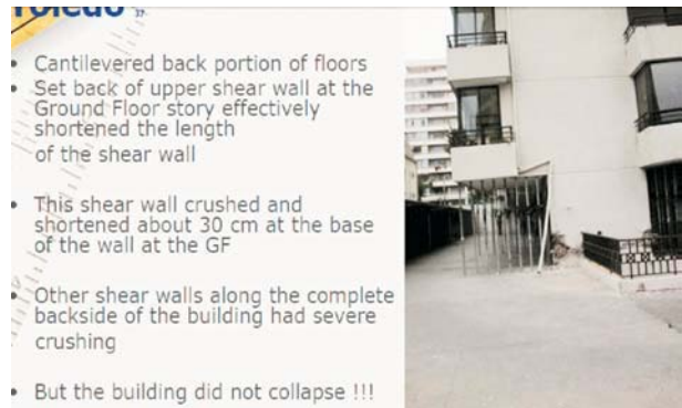
Şekil 12. Zemin katta küçültülmüş perde. Perdelerinde büyük hasara karşı yıkılmamış yapı. İleri düzeyde perde hasarı ile azalmış taşıma gücü yapı ağırlığı ve kullanım yüklerini taşımak için yeterli olduğu için tümü ile yıkılma olmamış.
