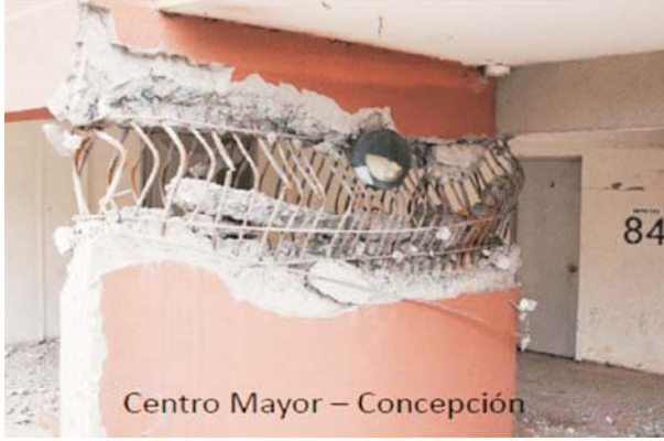
Şekil 7. Betonarme perdede basınç kırılması.
