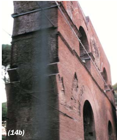
Şekil 14. (a), (b) Duvarların Köşelerinde Güçlendirme, Gergi Düzenlemesi (Su Kemer, Roma) (c) Çelik Hatıl Düzenlemesi (d) Hatılların Köşe Birleşimleri
