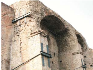
Şekil 17. Kemerlerde Gergi Düzenlemesi ve Mesnetlerin Sabitlenmesi (Roma Forumu'nda Yapı)
