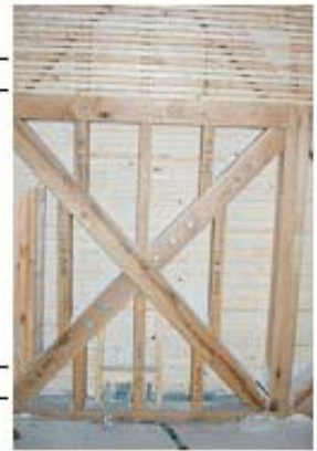
Şekil 11. (a), (b) Ahşap Kiriş Eki (Şişli Birkökler Vakfı Konağı) (c) Stabilité Çaprazı (Şişli Birkökler Vakfı Konağı)
