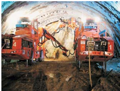
Şekil 15. Jumbo aygıtıyla patlayıcıların yerleştirileceği lağım deliklerinin açılış anında bir görünüm
