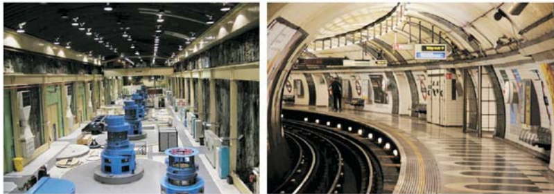
Şekil 14. Bir yeraltı hidroelektrik santraline ve metro istasyonuna ilişkin görüntüler (URL-13, 2008; URL-14, 2008)
