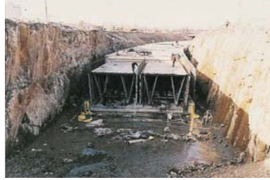
Şekil 18. Kaz-kapa yöntemiyle inşa edilen bir metro tüneli
