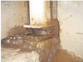
Şekil 5. Orta açıklık mafsals düzeneginin kutu kesit içersinden görünüşleri
