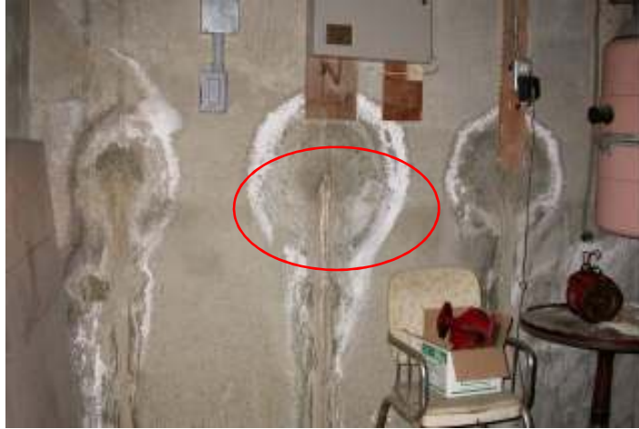
Yapısal Tamir Harçları ile Doldurulmamış Tij Delikleri
