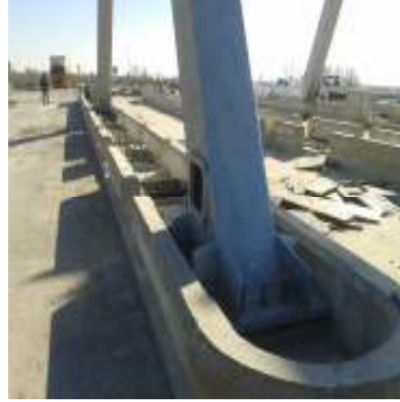
Çimento veya epoksi grout ile doldurulması
