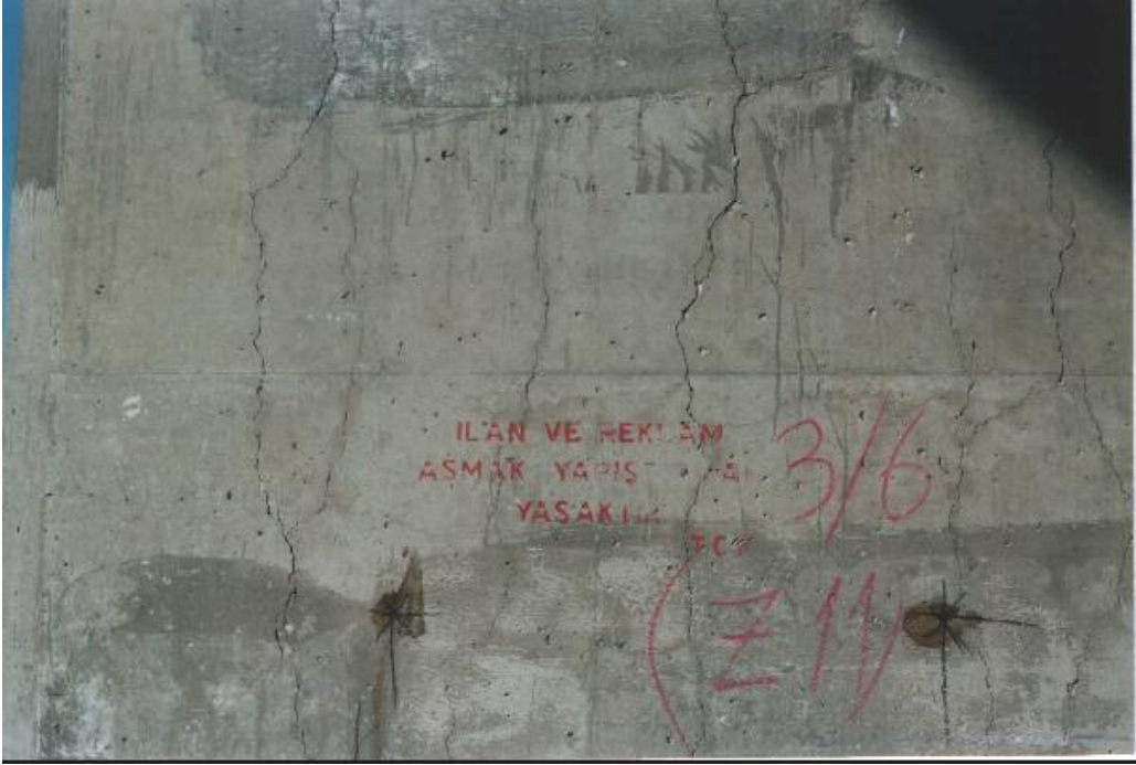
Resim 12. Alkali Silis Reaksiyonu (İzmir)
