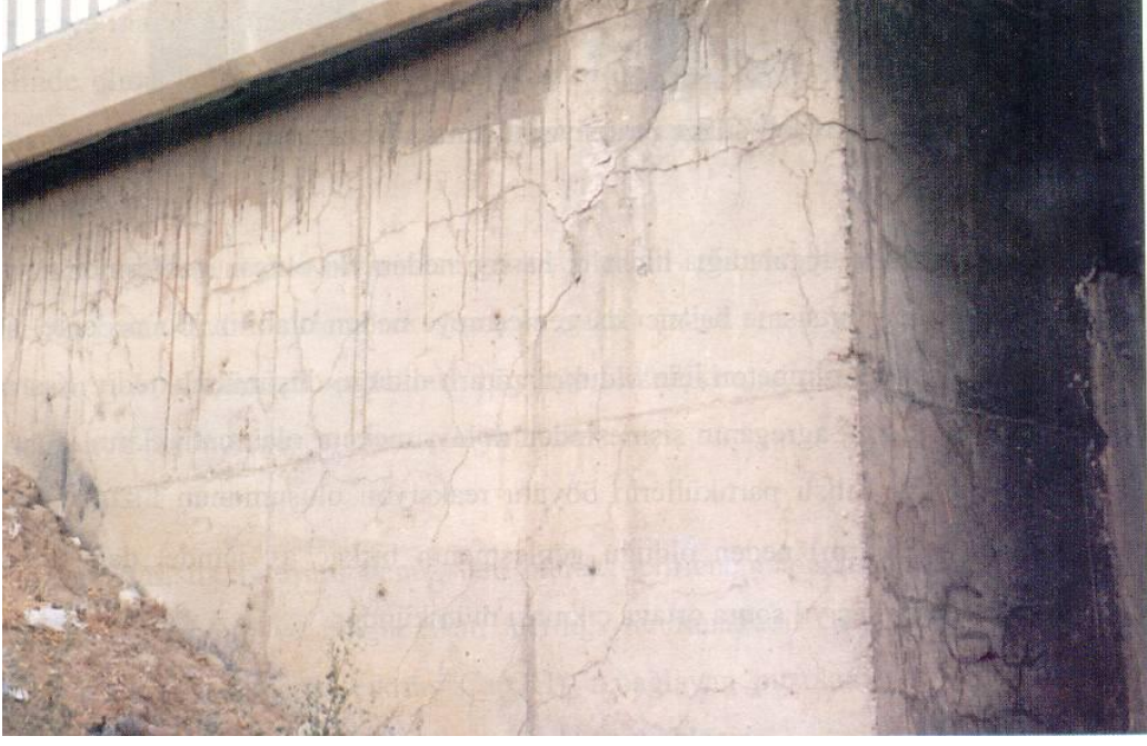
Resim 11. Alkali Silis Reaksiyonu (İzmir)
