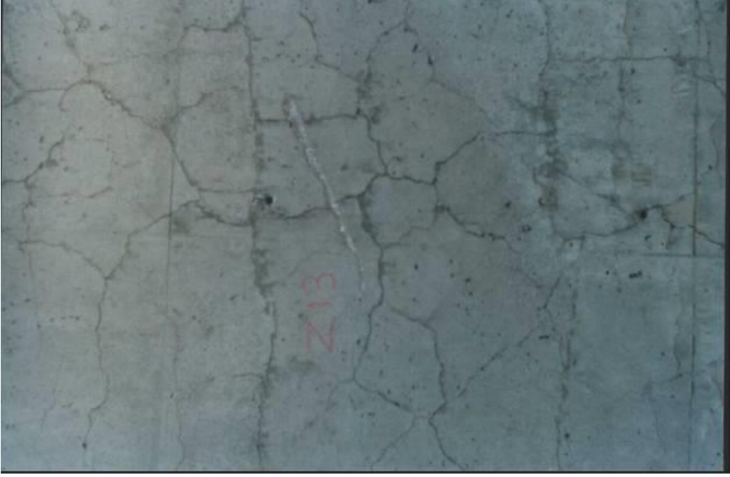
Resim 13. Alkali Silis Reaksiyonu (İzmir)
