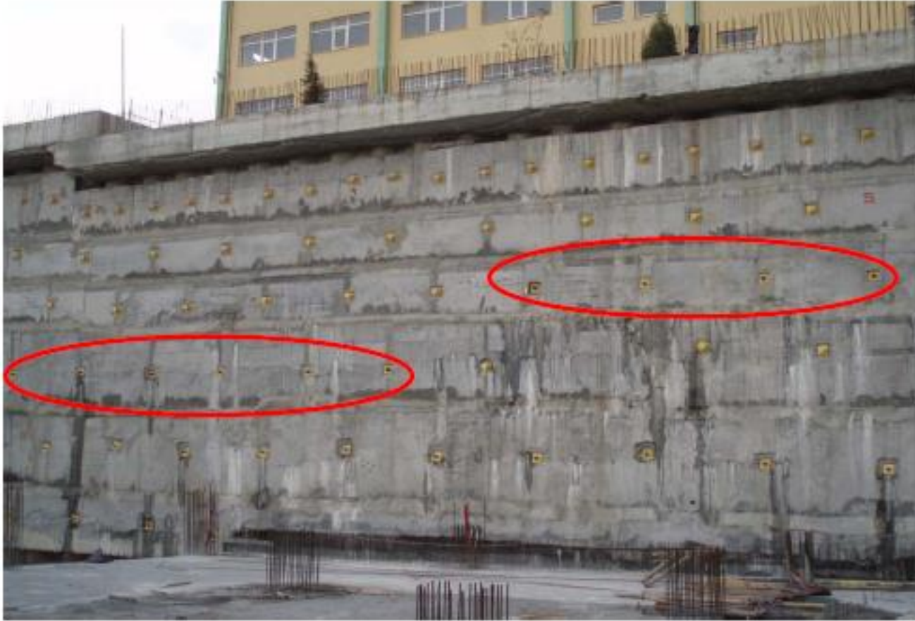
Geçici ankraj detayıyla imal edilmiş, projede kalıcı gözüken ankraj kafaları
