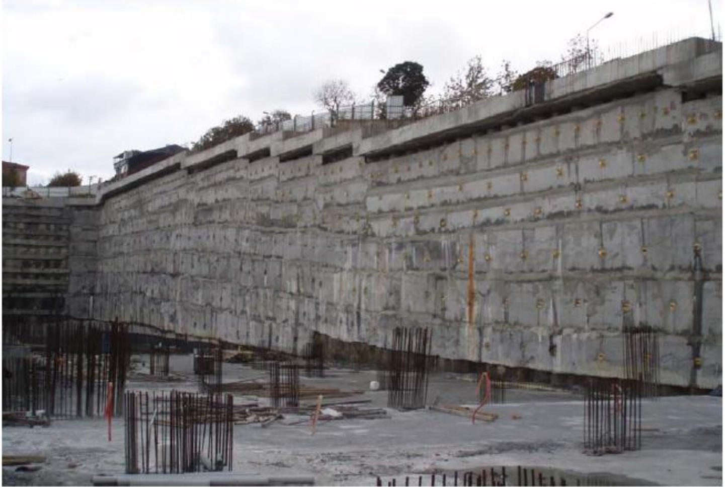
B'-C noktaları arası hatalı perde imalatı - barbakan eksikliği
