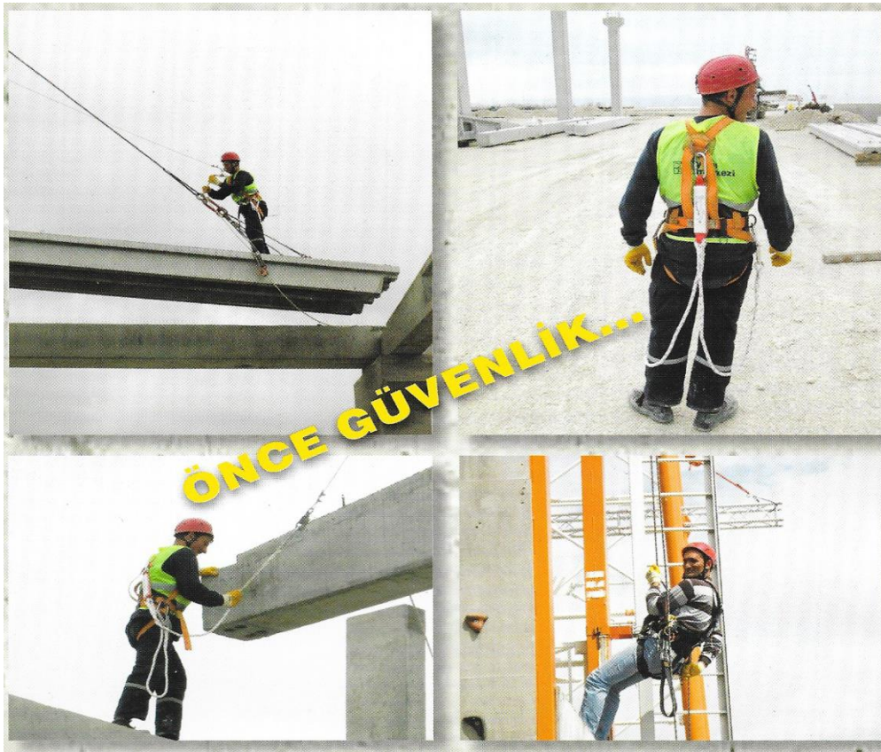
Kirişlere monte edilen koruyucu kılavuz halatlar
