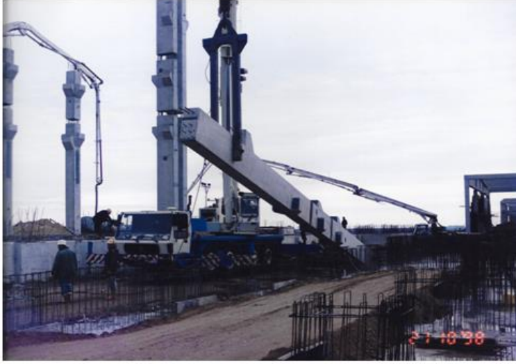
22 m uzunluğunda kolonun montajı
