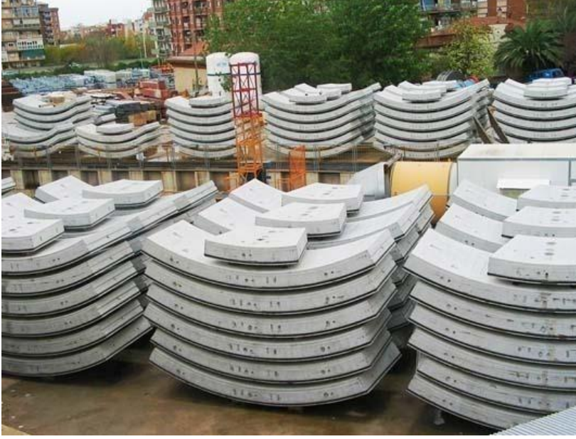
Tünel segmentleri stok sahası
