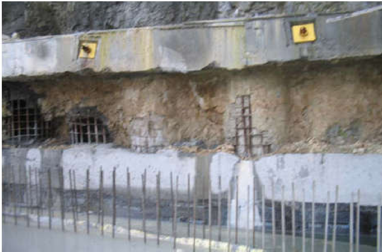
Gövde betonunda büyük boşluk (tam süreksizlik) bulunan kazıklar
