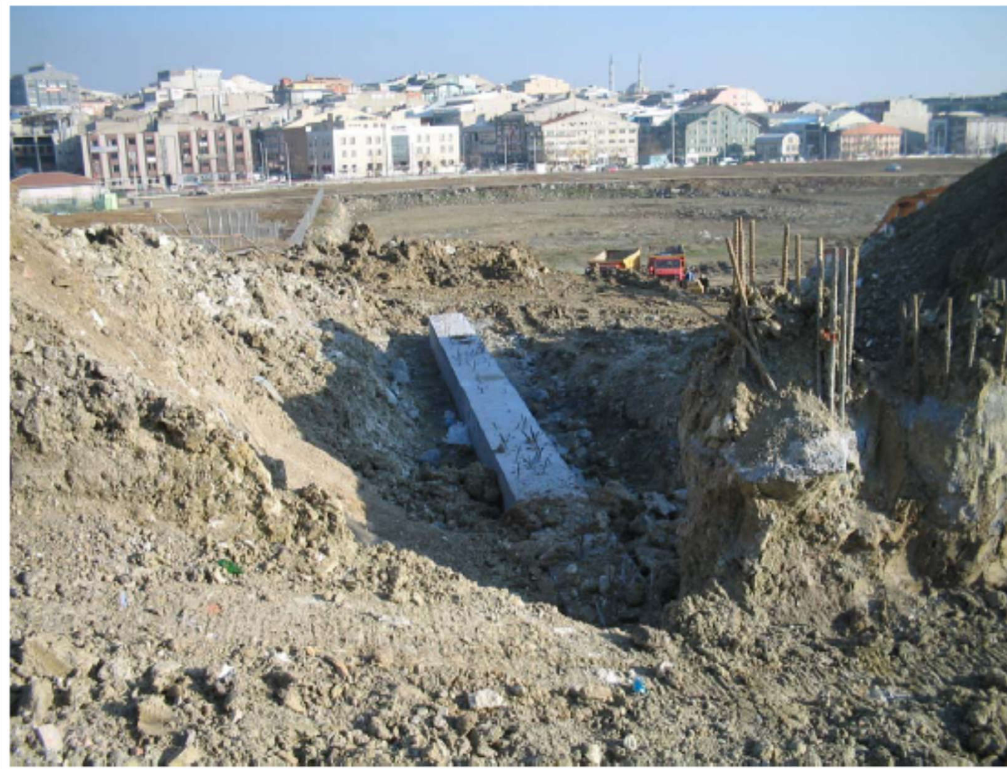
İksa Arkası Sürşarj Durumu
