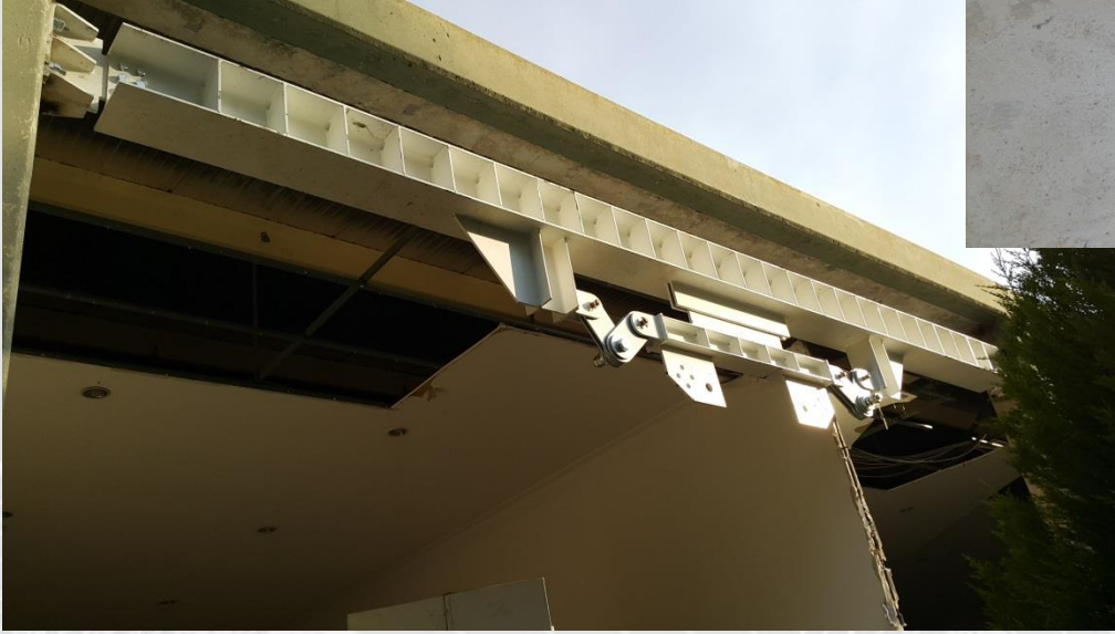
Sönümleyici Üst Kiriş ve Çapraz ayađı Montajı
