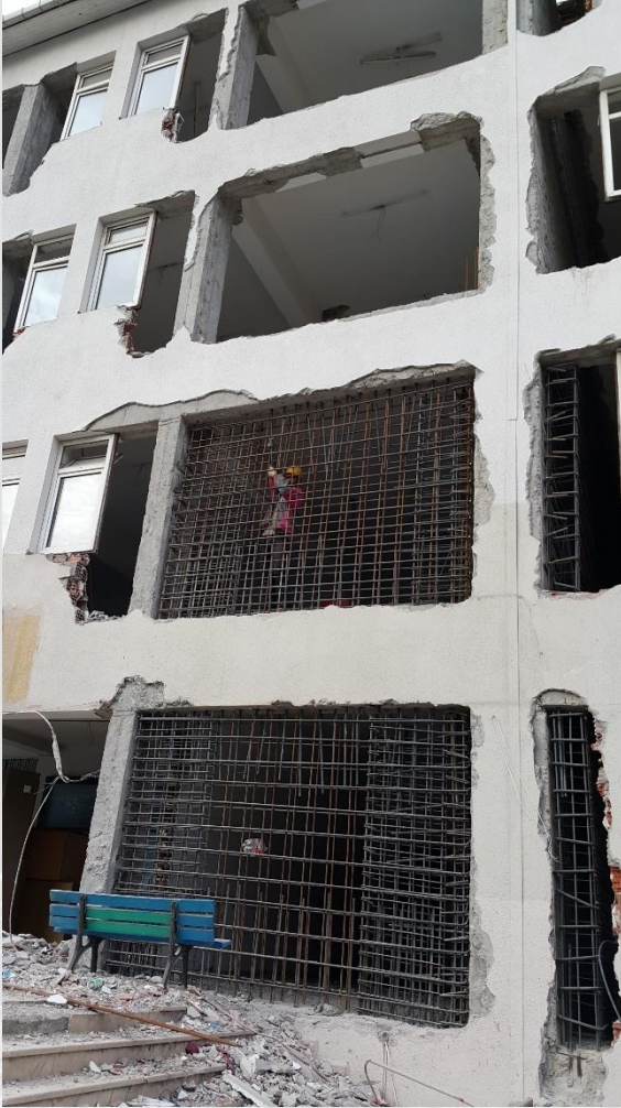
Çerçeve İçine Perde Ekleme Perde Donatıları
