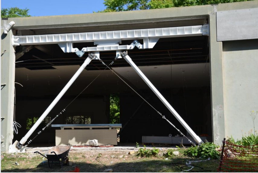
Sönümleyici Çapraz Uygulamaları
