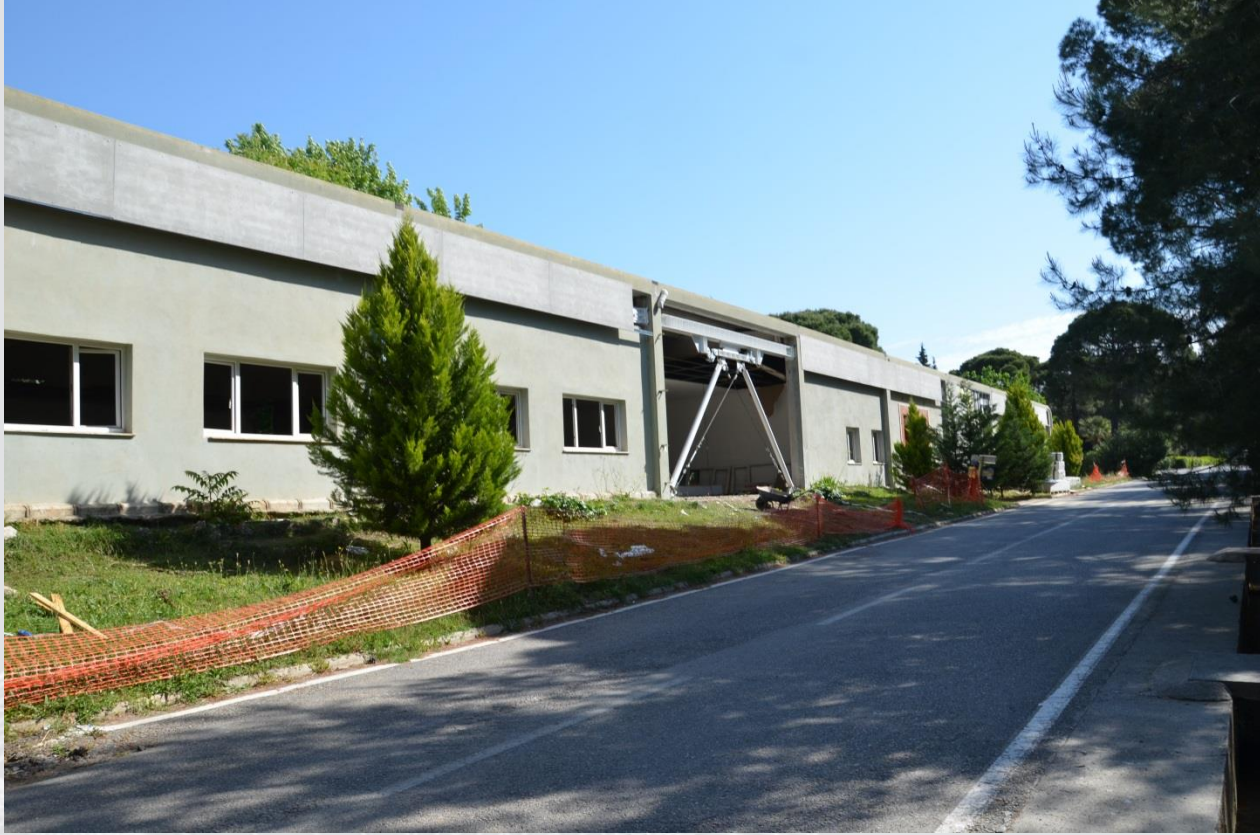
Uzun Yönde Sönümleyici Uygulaması
