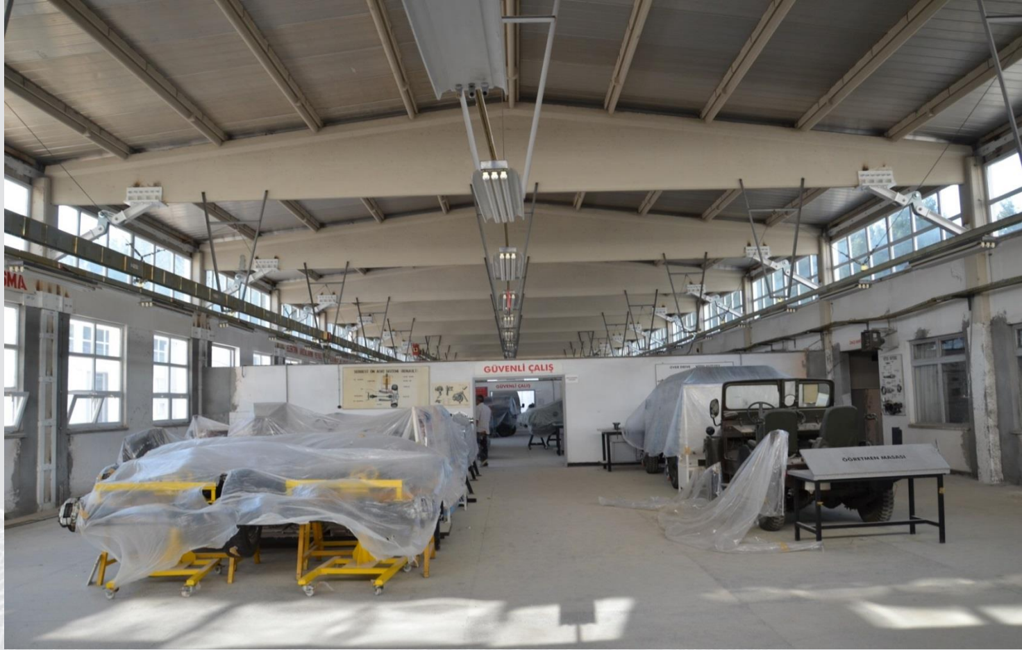
Beton Prefabrik Yapı Güçlendirmesi-Balıkesir
