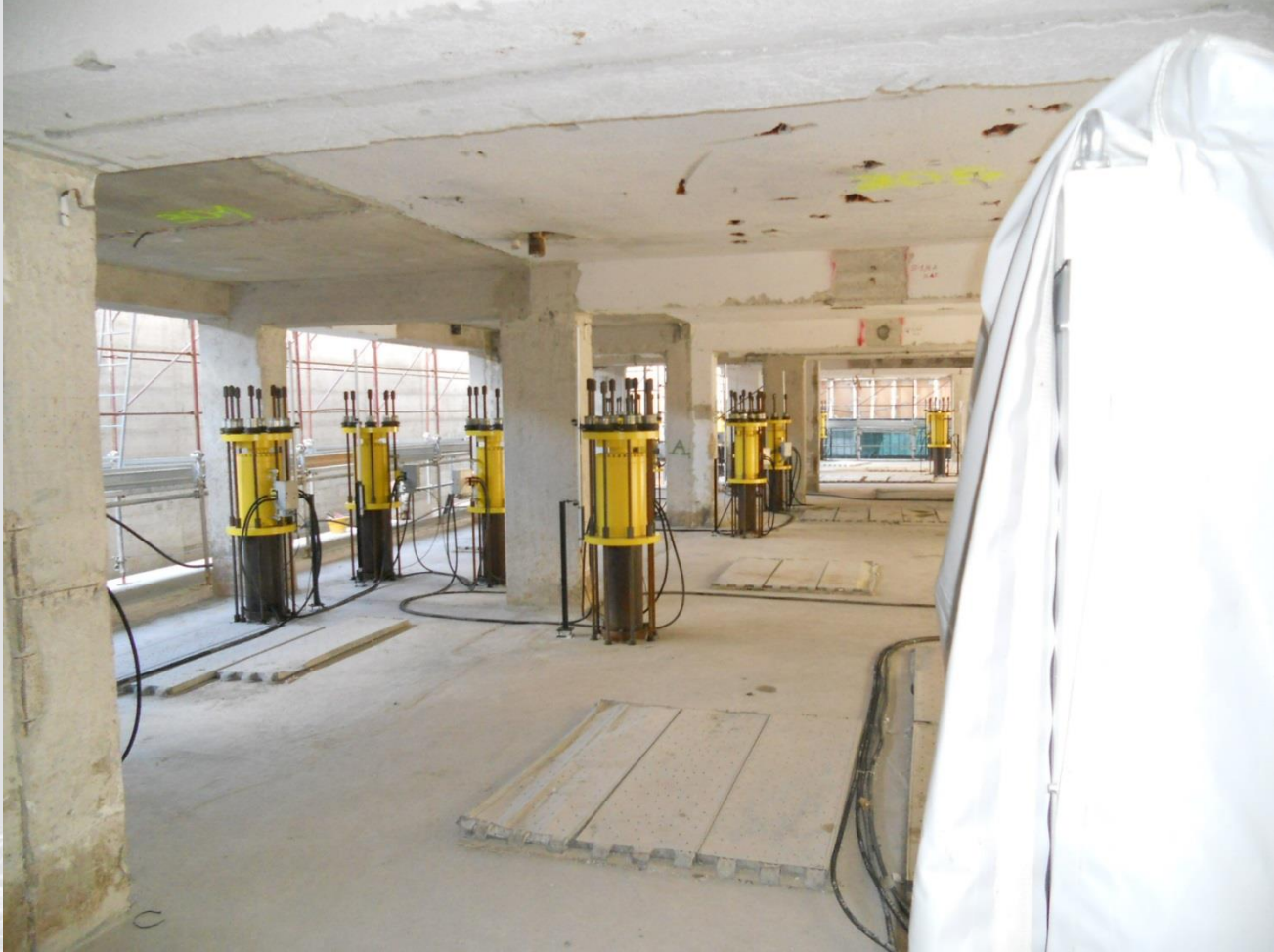
Yapıyı Yükseltecek Hidrolik Liftler
