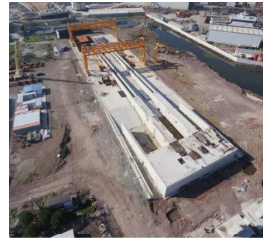
Şekil.23 Tabliye Yapım Alanı
