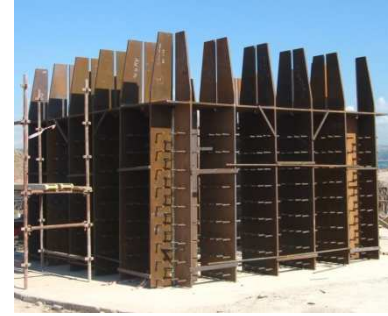
Şekil.9 Gömülü Çelik Ankraji
