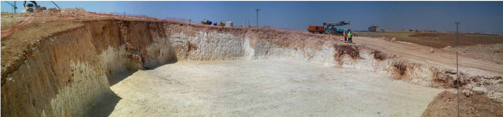
İksa Kazısı Öncesi Cephe Görünüşleri ve Şev Üstü Temel Kazıları
