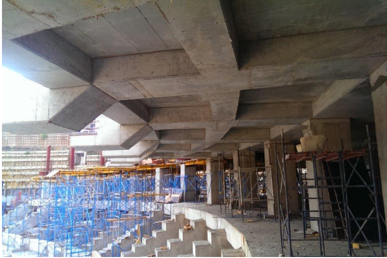
Şekil 17.Çelik –Beton Kompozit 12m. Konsol tirbün kirişleri
