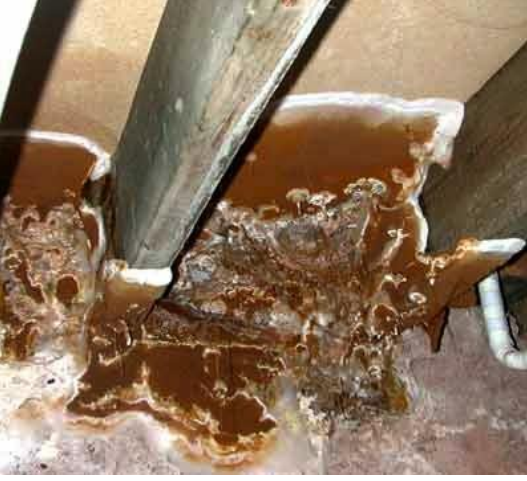
Ahşaptaki metal birleşimlerde korozyon hasarı
