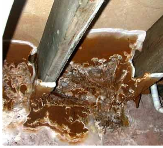
Ahşaptaki metal birleşimlerde korozyon hasarı
