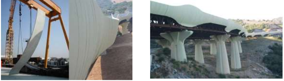
Şekil 8. Sinüzoidal beton kalkan parçası ve bu kalkan kabuğun yer aldığı viyadüğün göl tarafından görünümü [39].
