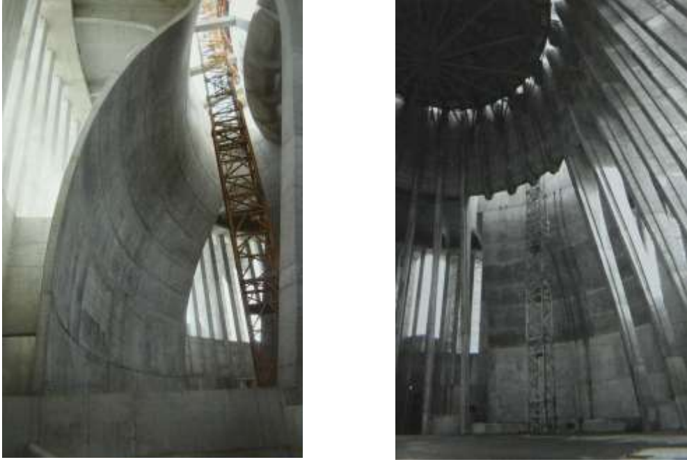
Şekil 6. İç mekanda üretilen eğri formdaki brüt beton elemanın kalıp alındıktan sonraki görünümü[38].
