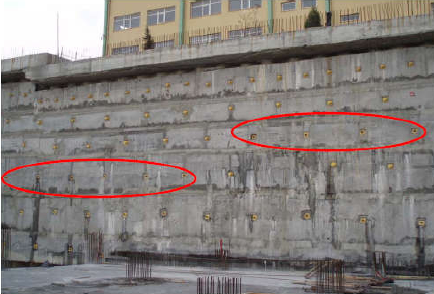
Geçici ankraj detayıyla imal edilmiş, projede kalıcı gözükten ankraj kafaları
