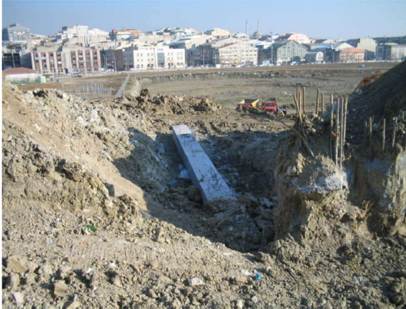
İksa Arkası Sürşarj Durumu
