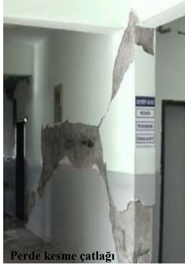
Kolonların hiç (çalışmadığı) katkı vermediği hasar
