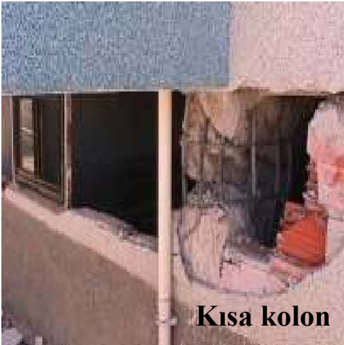
Kolonların hiç (çalışmadığı) katkı vermediği hasar
