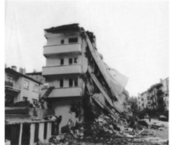
17 Agustos 1999 Marmara Depreminde yikilan binadan bir görünüş
